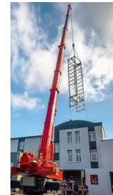
Montage eines Vertikalförderers
