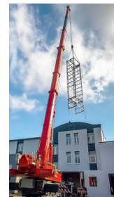
Montage eines Vertikalförderers
